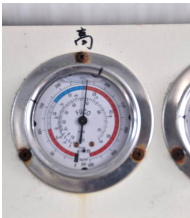
圖 7 清洗前設備使用電流 153.8A， 高壓 18.2 kg/cm 2 (警戒區)
