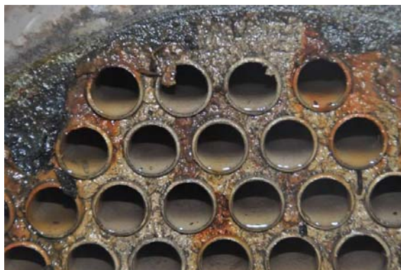
圖 2 清洗前系統結垢嚴重
