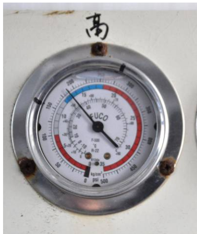
圖 10 清洗後電流下降至 120.5A，高壓 13.2 kg/cm 2
