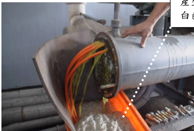
圖 3 熱交換器單管清洗初期
