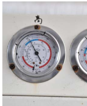
圖 8 清洗後電流下降至 127.1A，高 壓 14.6 kg/cm 2
