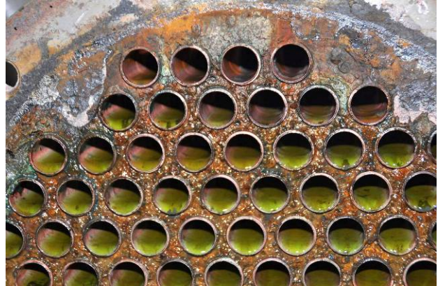
圖 6 清洗後水垢已清除
