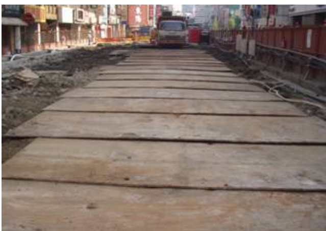
圖 8 車輛通行路徑鋪設鋼板
