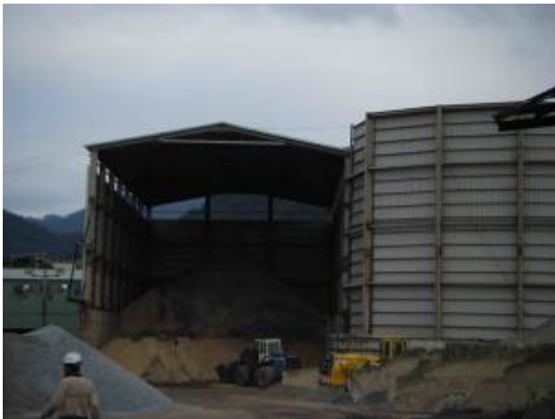
圖 6 粒料堆置區(圍封式)
