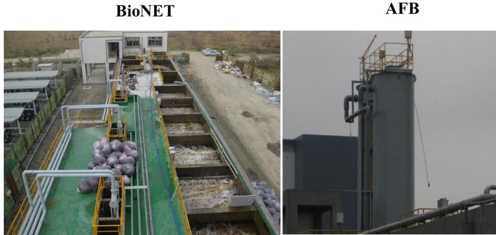
圖8 BioNET硝化+AFB脫氮廢水處理系統實際照片
