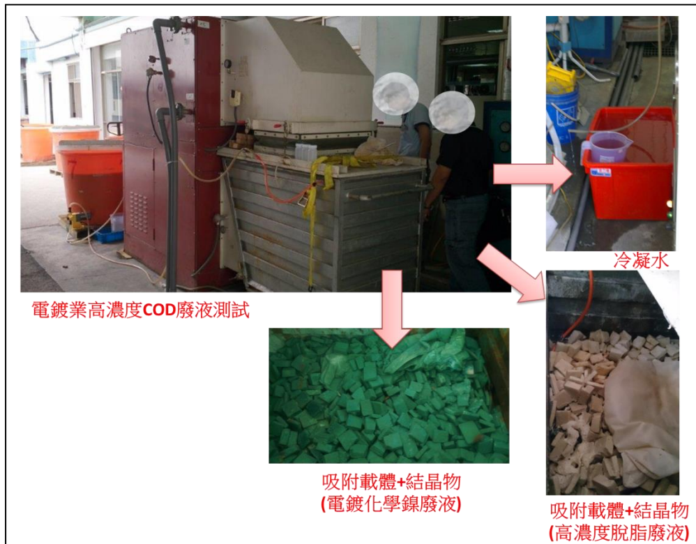
圖 3、機械蒸氣再壓縮系統測試現況
