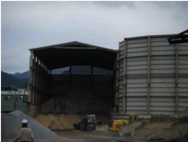
圖 11 粒料堆置區(圍封式)
