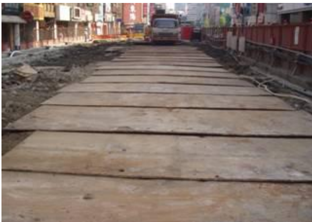
圖 13 車輛通行路徑鋪設鋼板
