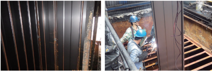
圖 5 新極板安裝後 (左)、新極板安裝過程 (右)
