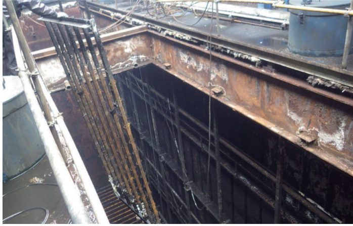
圖 4 舊極線移除後
