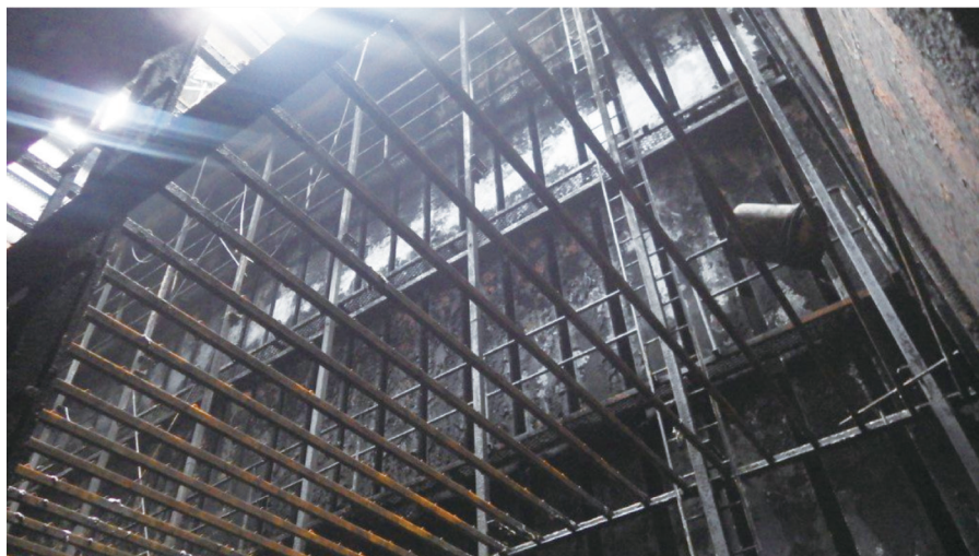
圖 3 舊極板移除後
