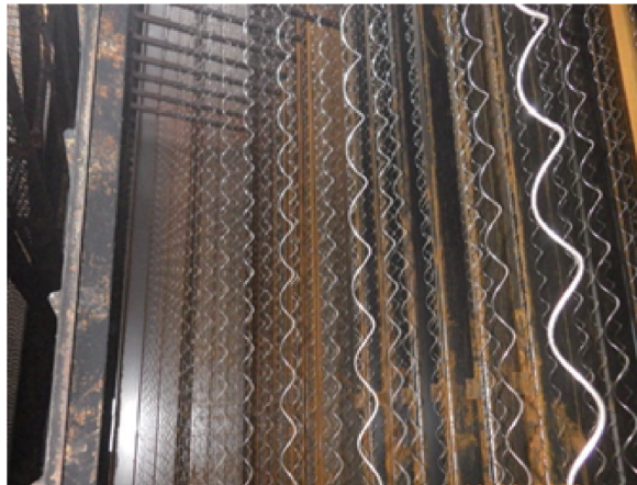
圖 6 新極線安裝後
