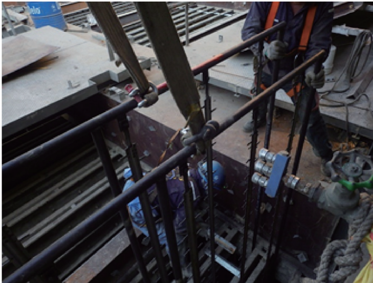
圖 9 新極線框與新極線安裝中
