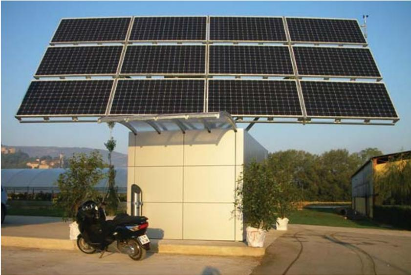
圖 7 Cellstrom 奧地利 10kW10h 太陽儲能 VRB 充電站<sup>[27]</sup>
