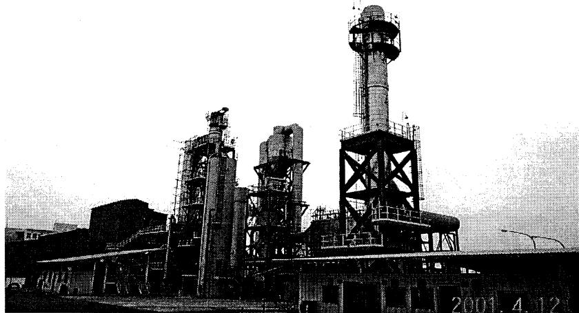
圖 1 旋窯式焚化爐
