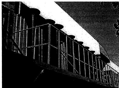
圖 6 排氣尾管及採樣設施
